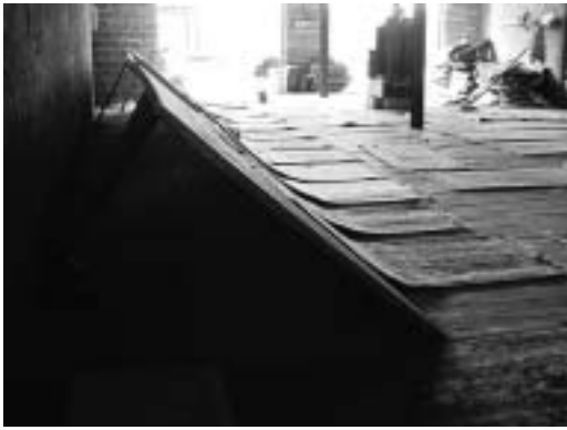
شکل ۹: دارکشی با میخ و تخته لولا
