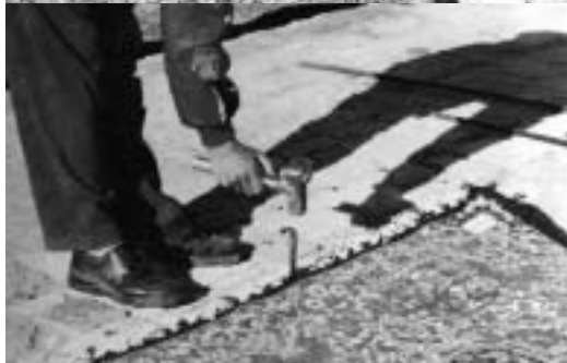
مجموعه شکل ۲۶: محکم کردن فرش با میخ‌های مخصوص
