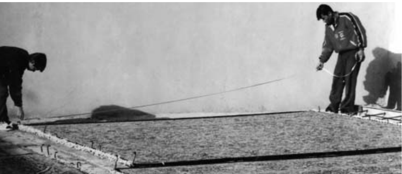
شکل ۲۹: مراحل مختلف عملیات گونیا کردن
