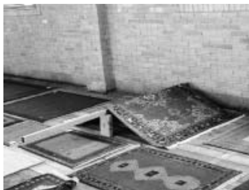
شکل ۱۶: عملیات کشش مضاعف
